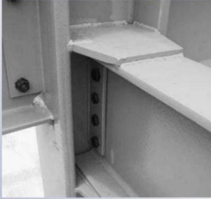
Conexión a momento con placa en la aleta (soldada)
