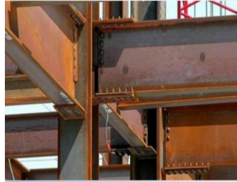
Conexión a momento con placa en la aleta (pernada)
