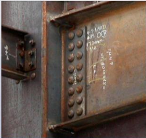
Conexión a momento con soldadura directamente en la aleta
