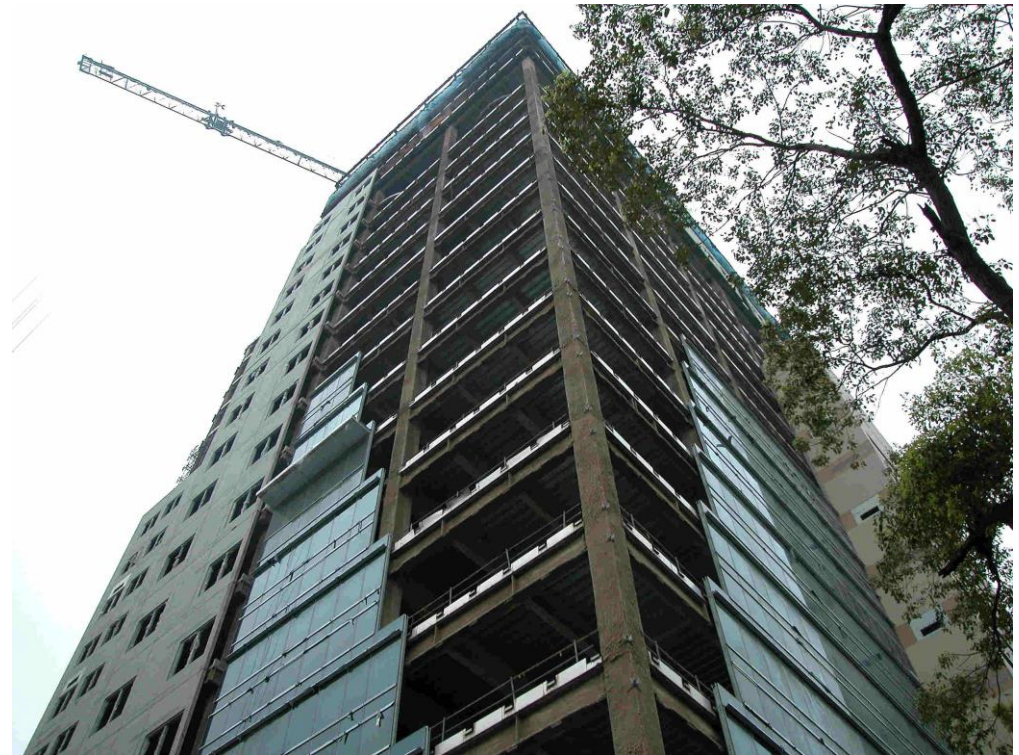
Pórtico resistente a momento. Fuente: Design of Seismic-Resistant Steel Building Structures. 2. Moment Resisting Frames. Michael D. Engelhardt. 2007
